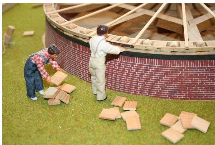
Gemetselde ringmuur, waarop de ringvormige ‘rolring’ ligt..
