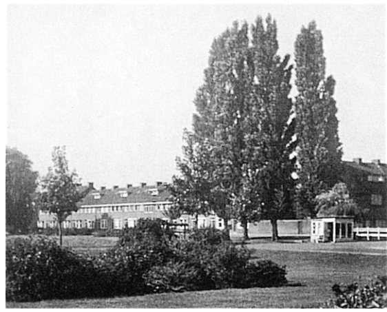
Dezelfde schut (boven de struik) v.u. het noorden met rechts de 'Witte Brug' over de Wetering en de bloemenstal 'van Haasjes' (What's in a Name) op de hoek van de A. Beyerkaade en de W. Arntskade.
