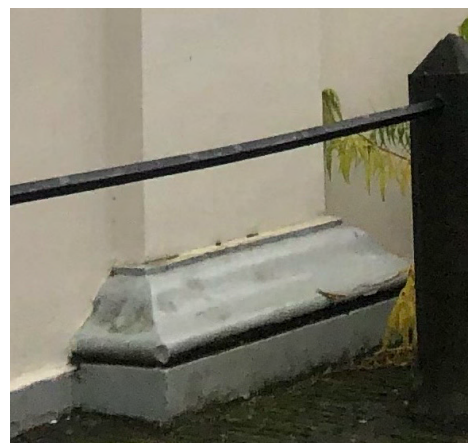
Detail gevel pilaster ca.1840
